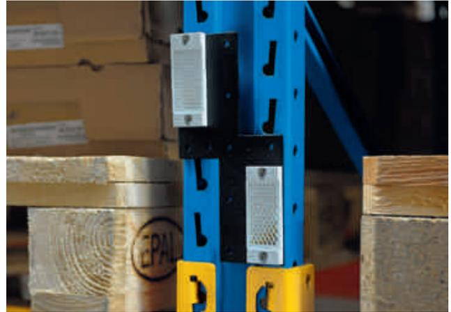
Abb. 19: Gangendesicherung über Reflexlichtschranken
