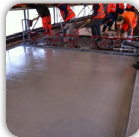
Druckfester Sanierungsbeton Verarbeitung
