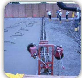
Brückenbetonage mit 18,5 m Spannweite
