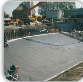
Rundklärbecken mit 15 m Spannweite
