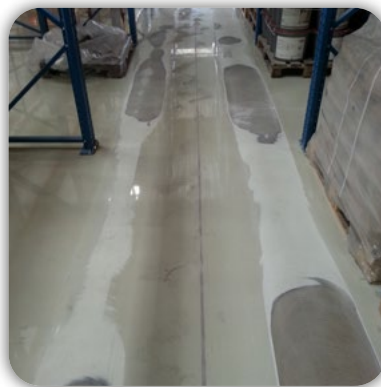
Fahrspur nach dem Schleifen der Hochpunkte
