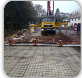
Elektrobohle mit W Profilierung - 3 Neigungswechsel
